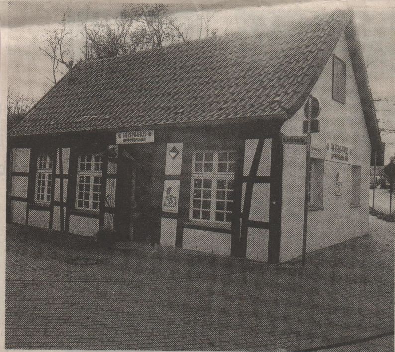
Dank privater Initiative konnte das ehemalige Südtorhaus vor dem entgeltlichen Verfall gerettet werden.
